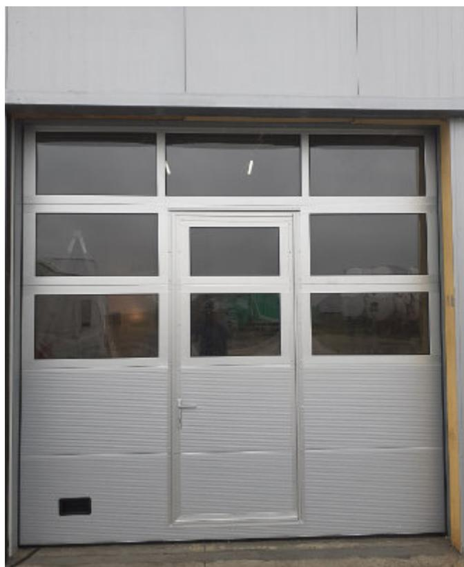
slika 15. Segmentna panorama vrata sa ugrađenim pešačkim vratima
