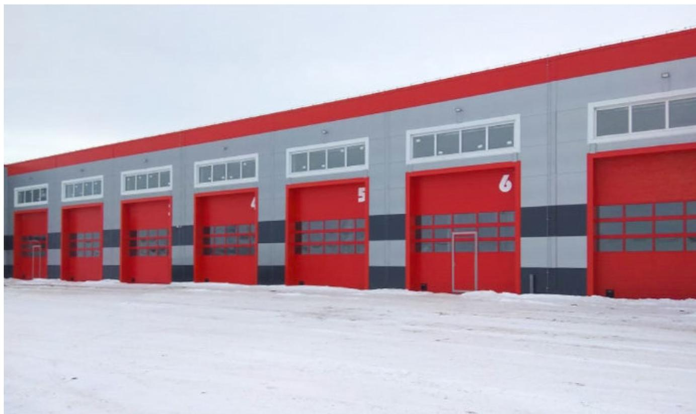
slika 16. Segmentna panorama vrata sa ugrađenim pešačkim vratima
