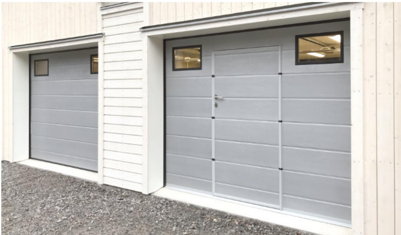
slika 3. Segmentna garažna vrata sa integrisanim prozorčićima i pešačkim vratima
