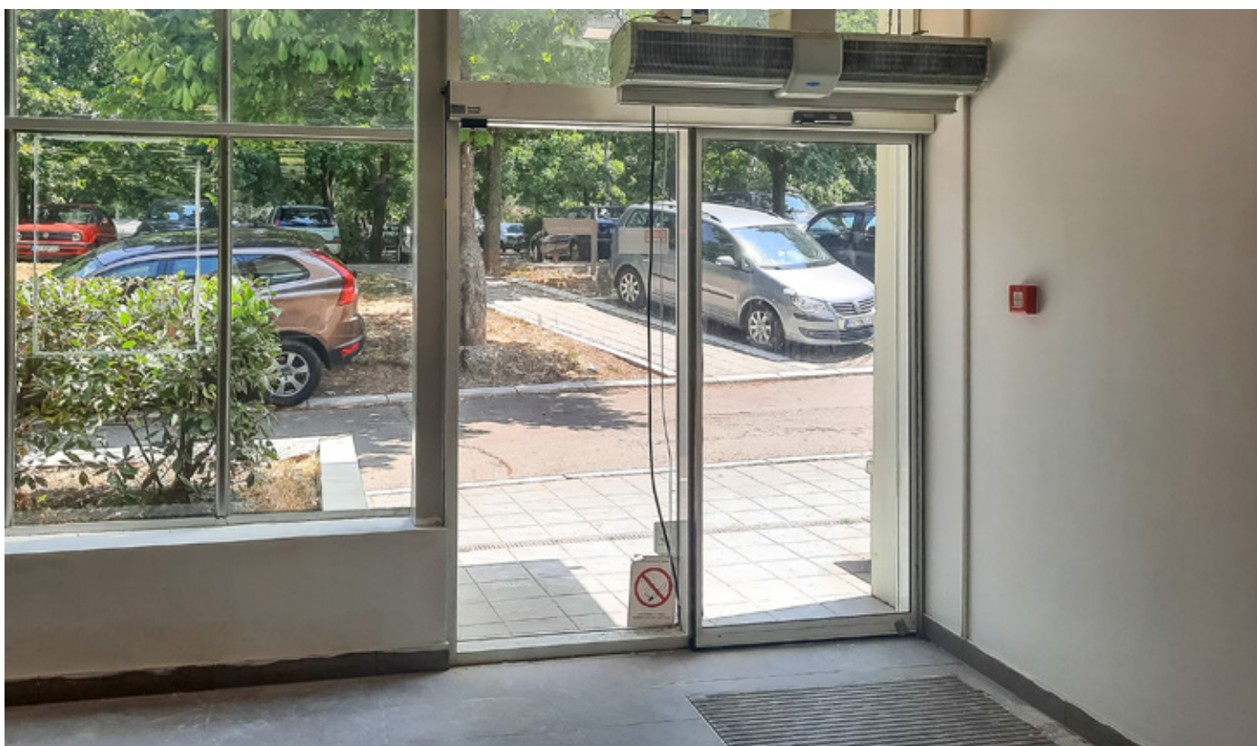
slika 4. Jednokrilna automatska klizna vrata sa vazdušnom zavesom iznad vrata
