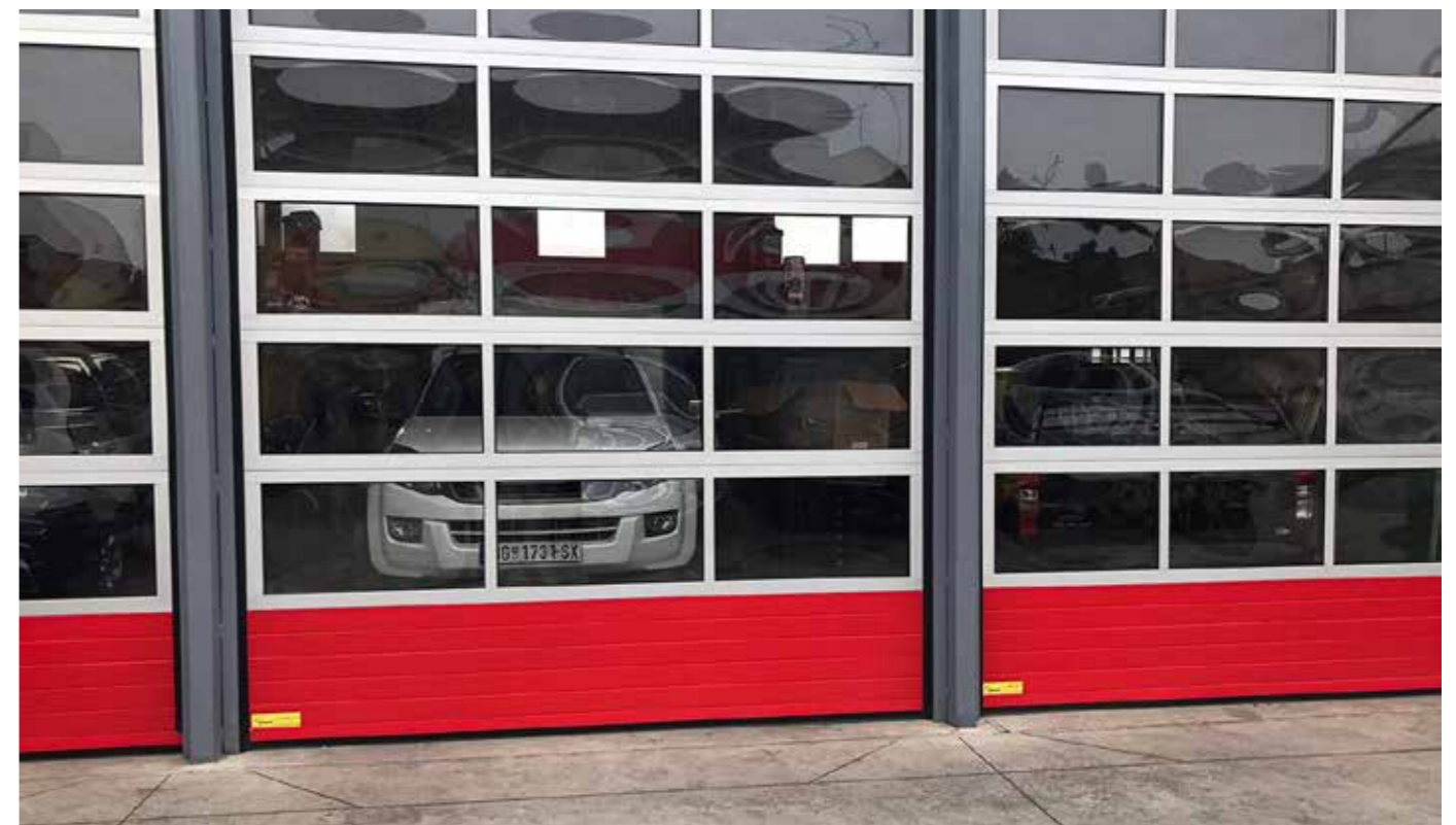
slika 26. Segmentna panorama full vision vrata sa aluminijumskim panelima i transparentnim dvostrukim pleksiglasom
