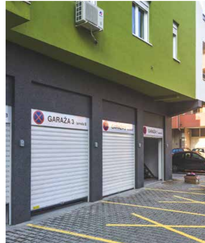
slika 3. Čelična rolo vrata sa punim lamelama
