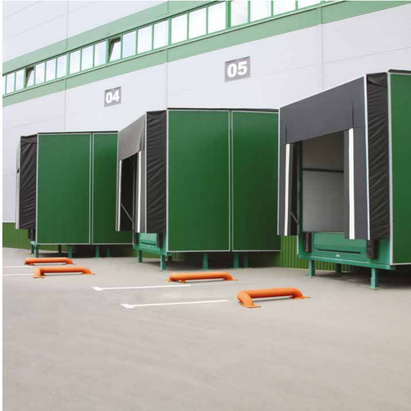
slika 48. Utovarne kućice (Dock Houses) ispred objekta. Ugradnja pod raznim uglovima.
