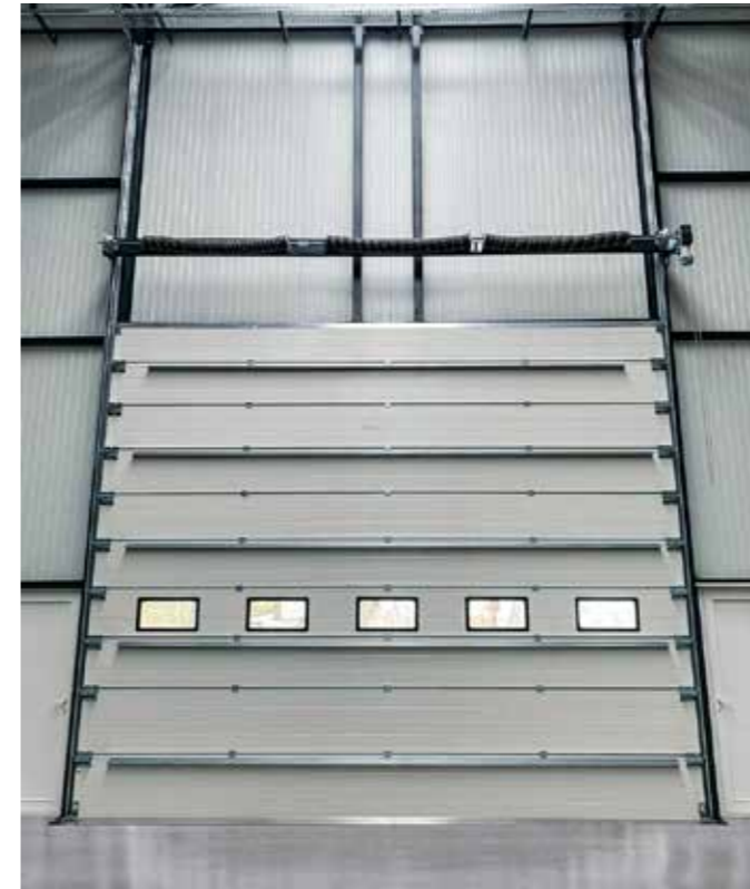
slika 20. Pogled industrijskih vrata sa unutrašnje strane, ojačani paneli, niska montaža, opruga Dock system
