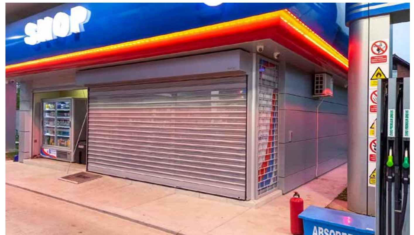
slika 5. Čelična rolo vrata sa perforiranim lamelama
