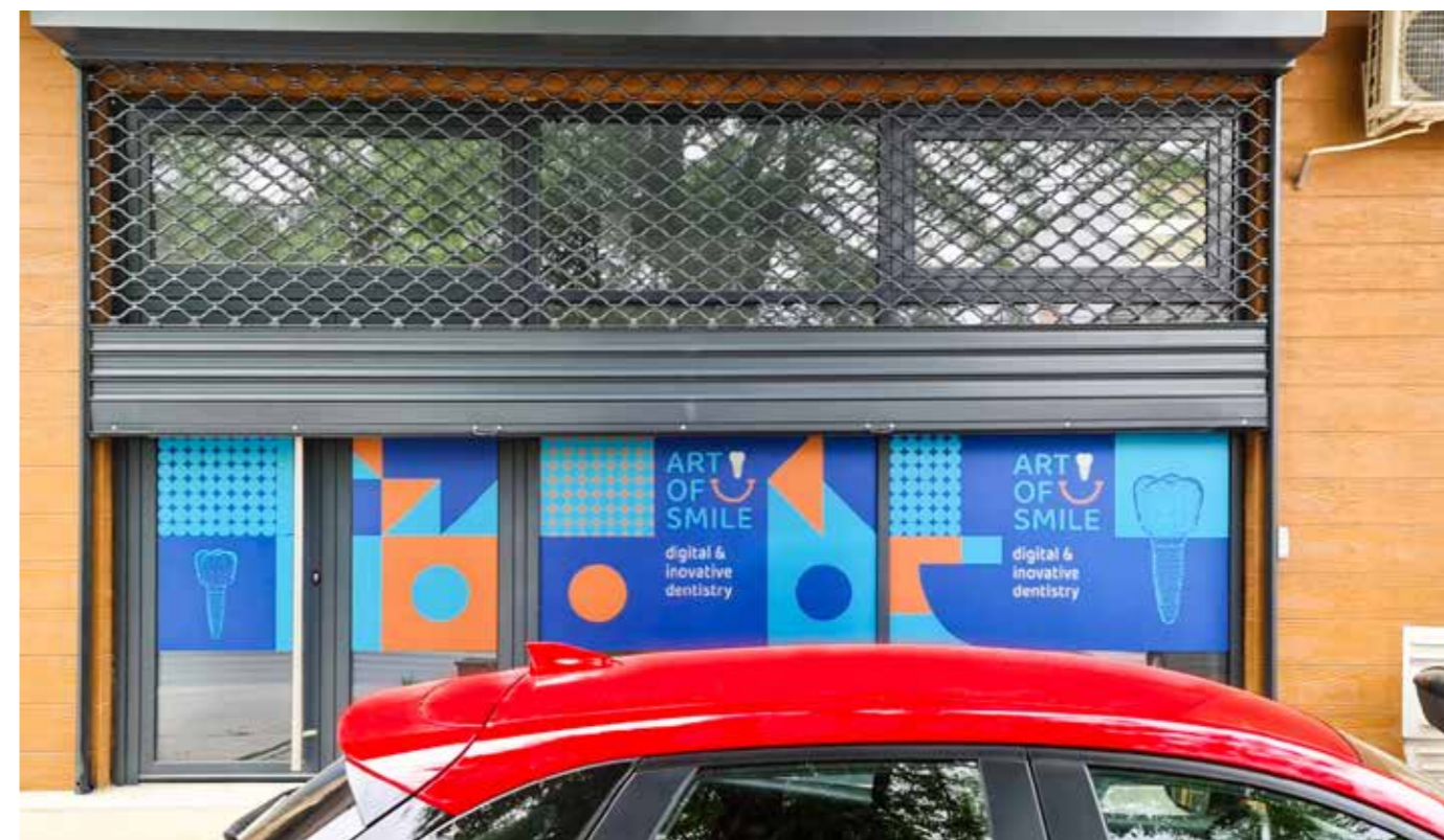
slika 12. Rolo vrata sa sinusoidnom rešetkom
