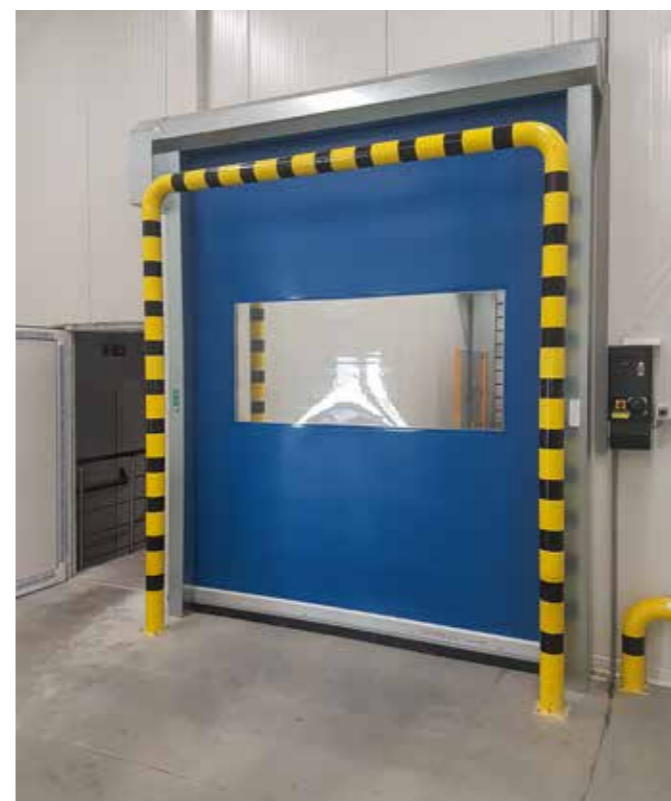
slika 34. PVC brza vrata sa zaštitnim čeličnim ramom i transparentnim delom za vizuelnu komunikaciju
