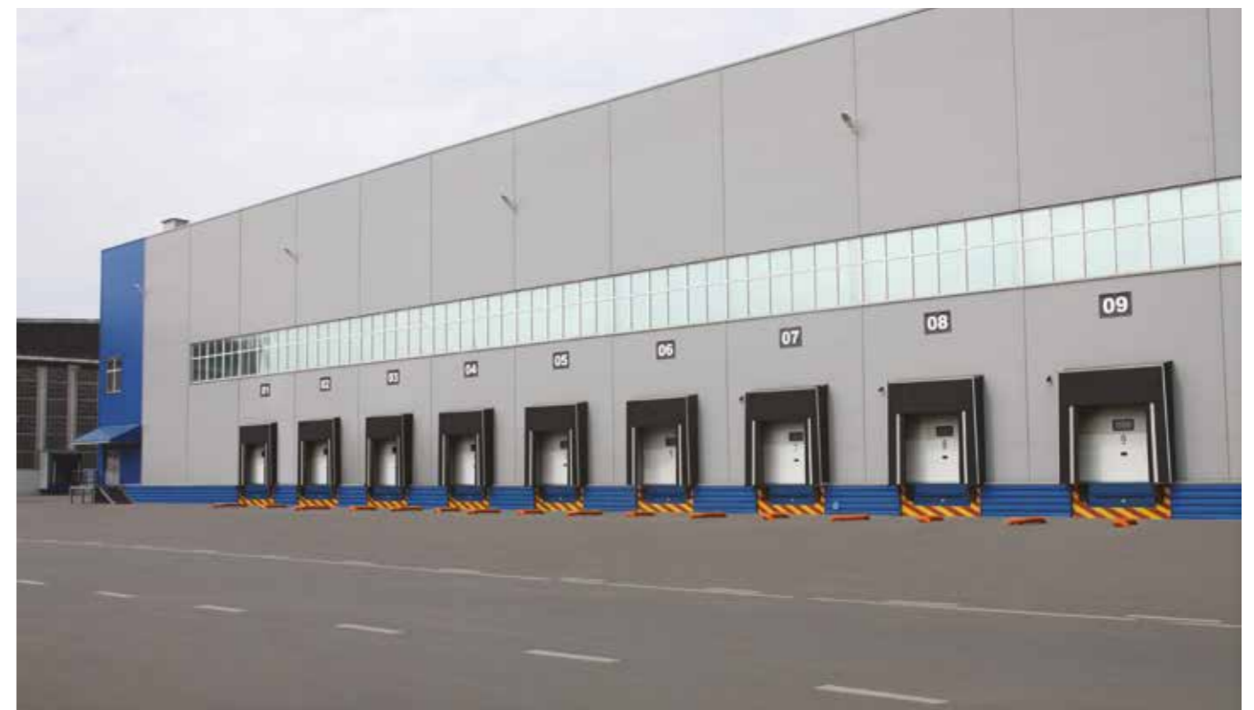
slika 51. Dichtung zavesa (Dock Shelters) sa metalnim uvodnicima za točkove vozila. Logistički centar
