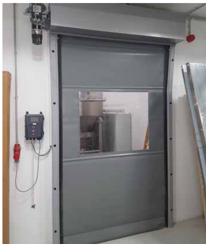
slika 31. PVC brza vrata sa transparentnim delom za vizuelnu komunikaciju
