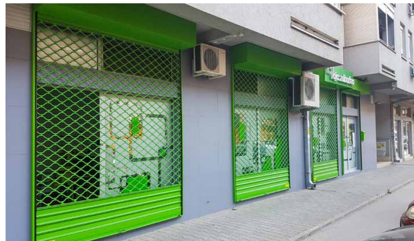
slika 13. Kombinacija sinusoidnih rolo rešetki sa punim lamelama
