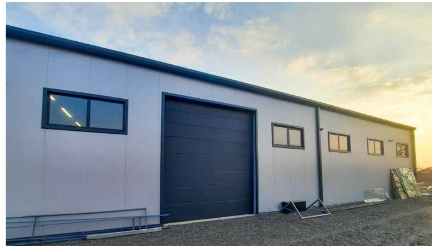
slika 22. Segmentna industrijska vrata, antracit boja (RAL 7016)
