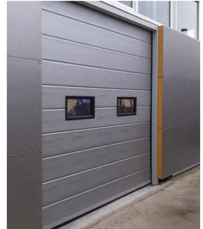
slika 21. Segmentna industrijska vrata sa integrisanim prozorima, siva boja (RAL 9006)
