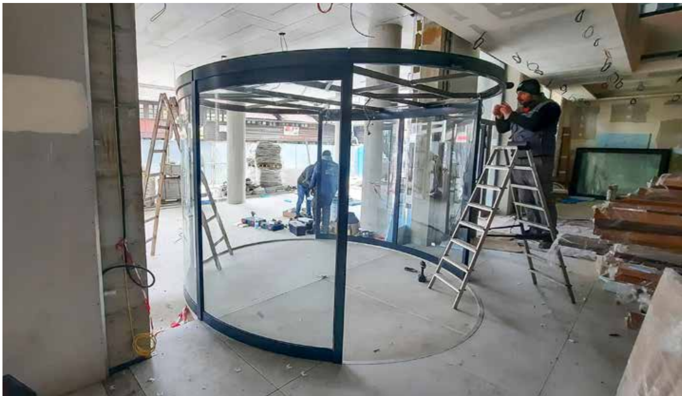
slika 39. Rotaciona (karusel) automatska vrata
