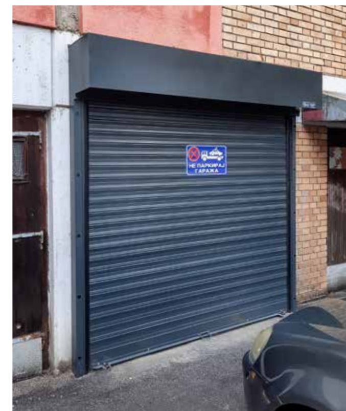
slika 9. Termoizolovana rolo vrata kao garažna vrata
