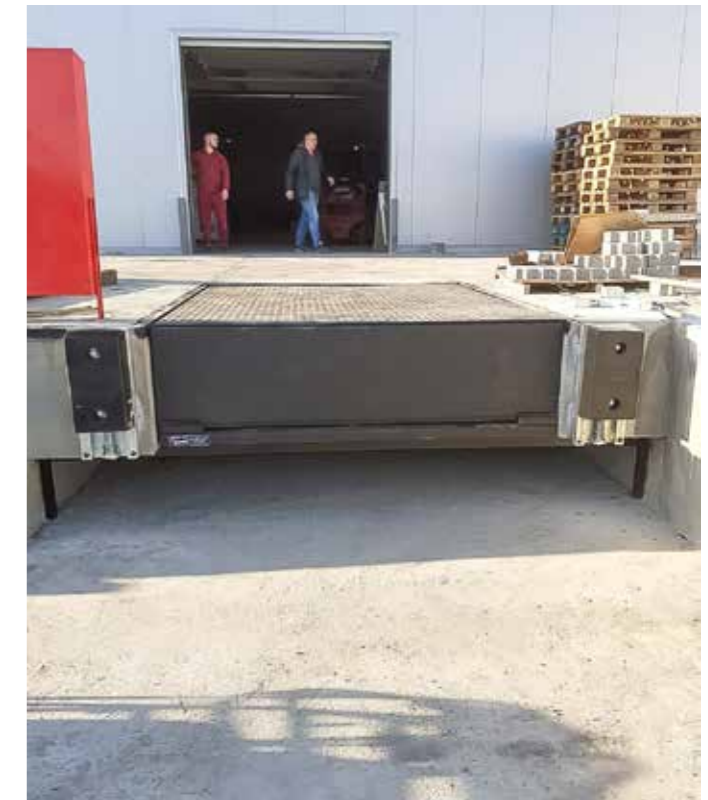
slika 46. Elektrohidraulična preklopna rampa sa prostorom ispod za podvlačenje zadnje rampe na kamionima
