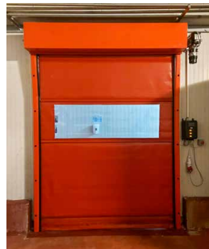
slika 35. PVC brza vrata sa transparentnim delom za vizuelnu komunikaciju
