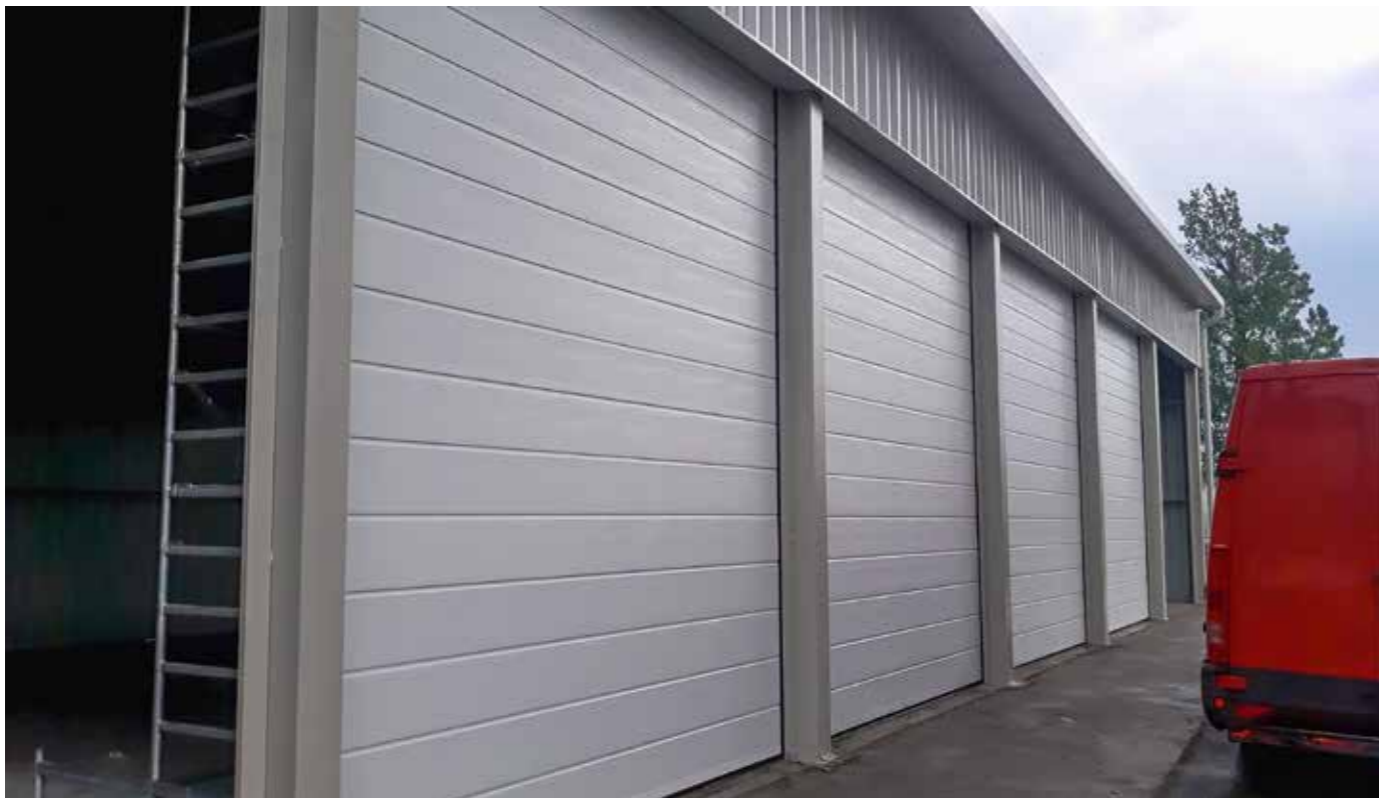
slika 19. Segmentna industrijska vrata, siva boja (RAL 9006), panel sa jednom srednjom linijom
