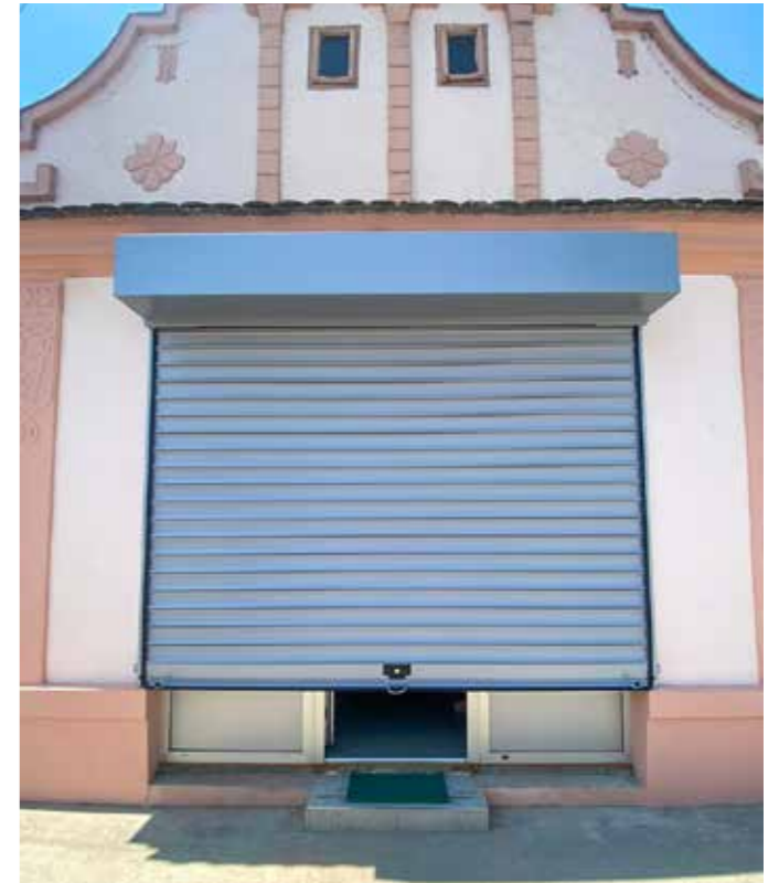
slika 4. Čelična rolo vrata sa punim lamelama
