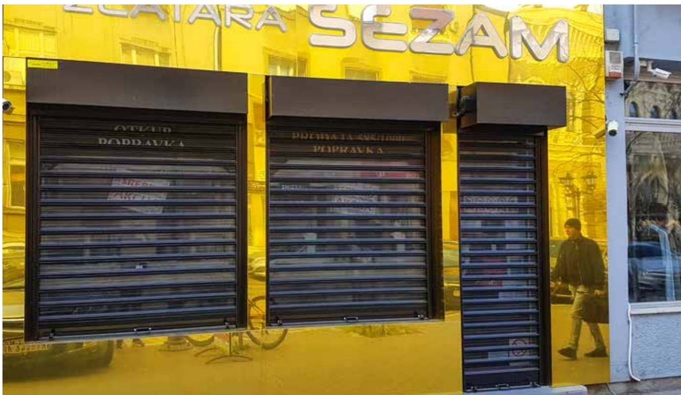
slika 2. Čelična rolo vrata sa perforiranim lamelama
