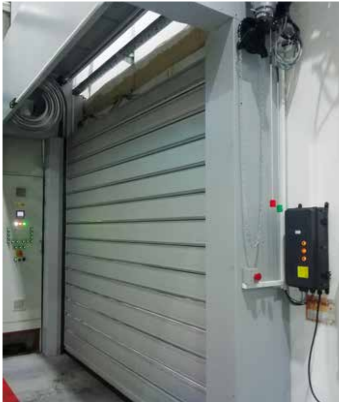
slika 27. Spiralna brza vrata sa termo panelima debljine 42 mm
