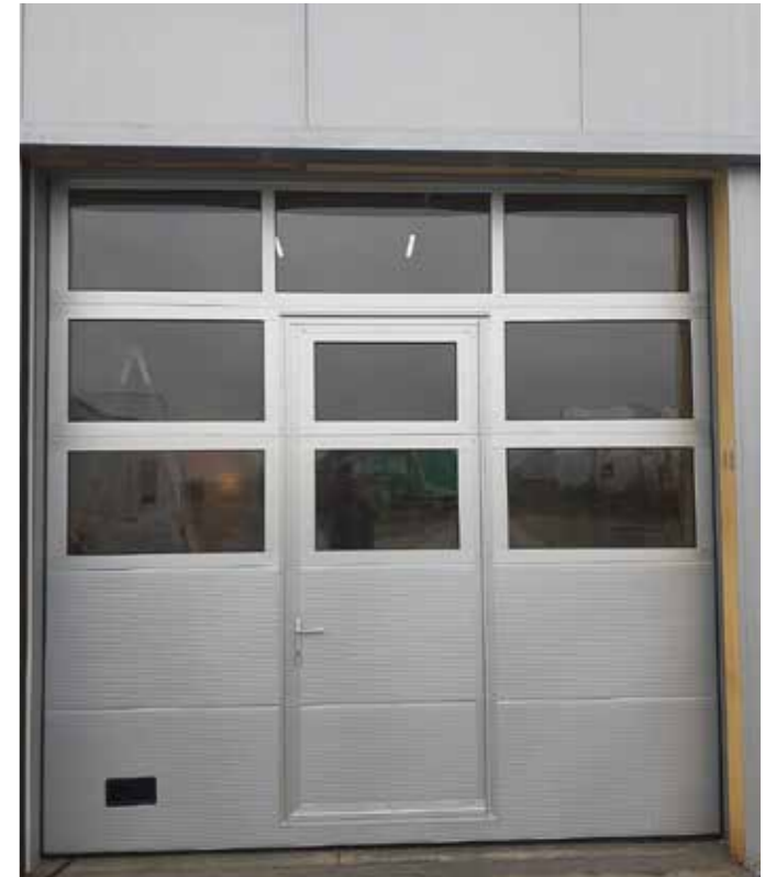
slika 25. Segmentna panorama vrata sa ugrađenim pešačkim vratima.
