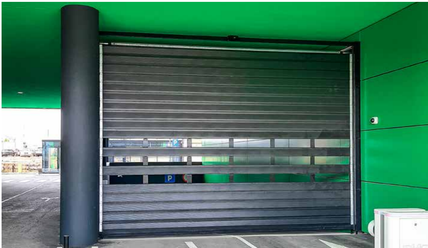
slika 29. Spiralna brza vrata sa transparentnim ventilirajućim otvorima
