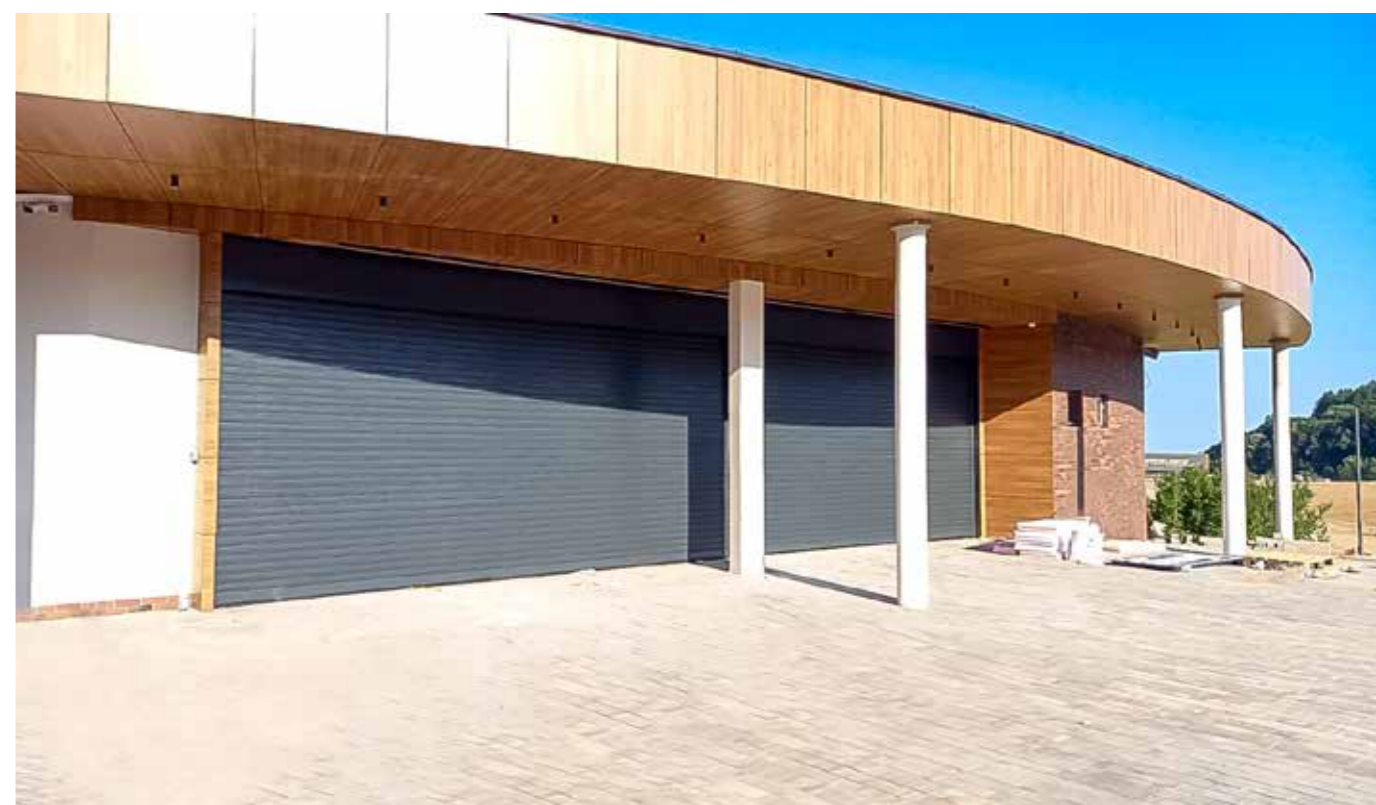
slika 10. Termoizolovana rolo vrata kao garažna vrata
