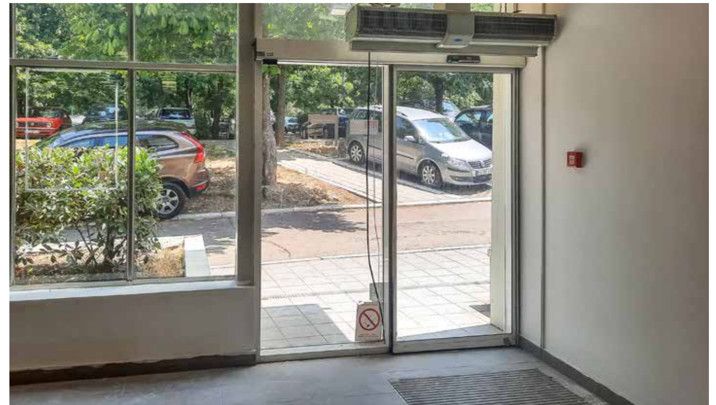
slika 42. Jednokrilna automatska klizna vrata sa vazdušnom zavesom iznad vrata
