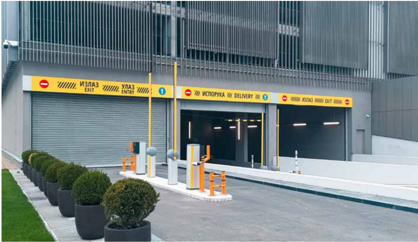
slika 1. Čelična rolo vrata sa punim lamelama bez izolacije
