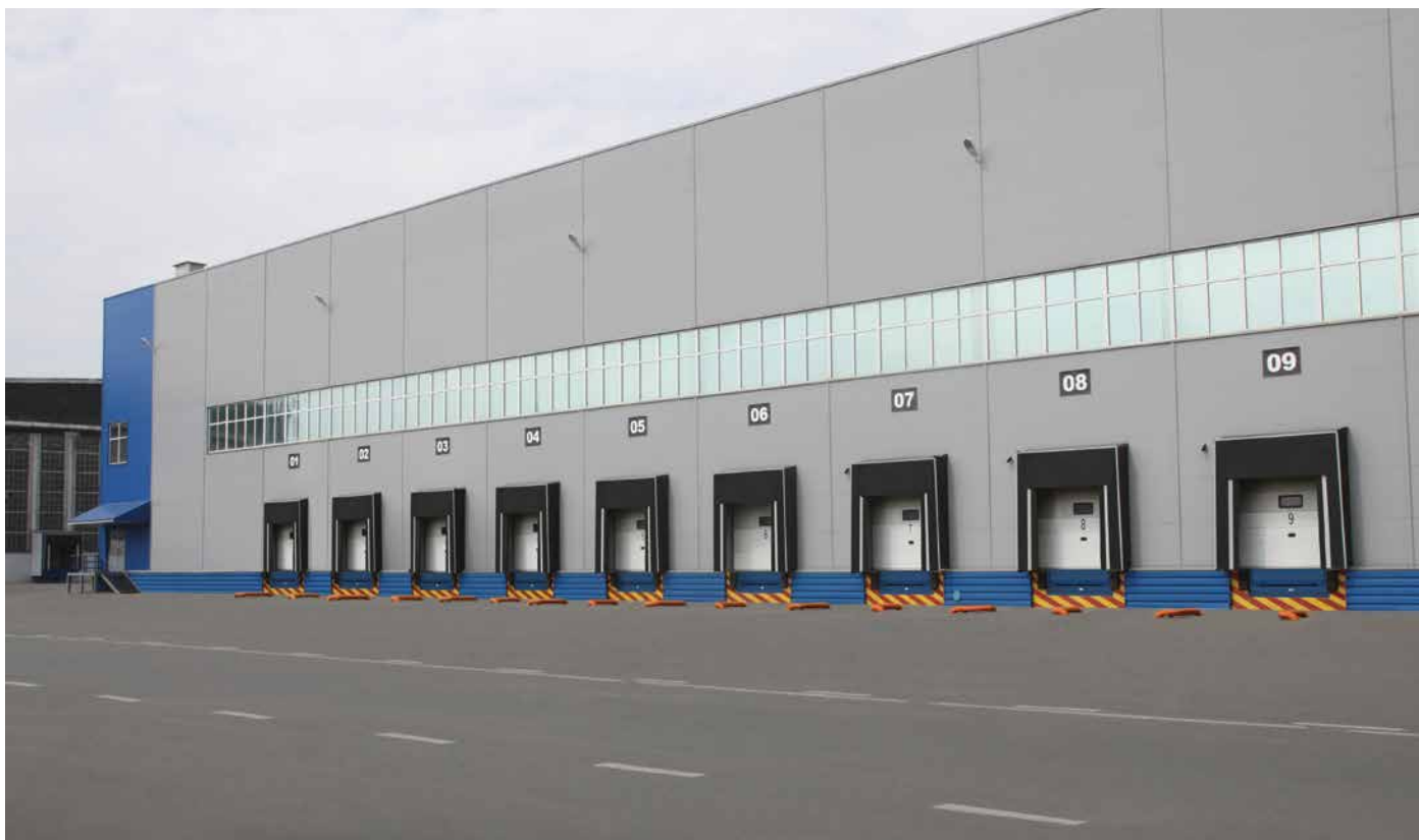
slika 11. Dichtung zavese (Dock Shelters) sa metalnim uvodnicima za točkove vozila. Logistički centar
