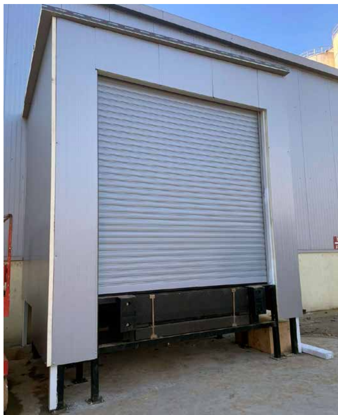
slika 9. Utovarna kućica sa elektrohidrauličnom rampom i rolo vratima
