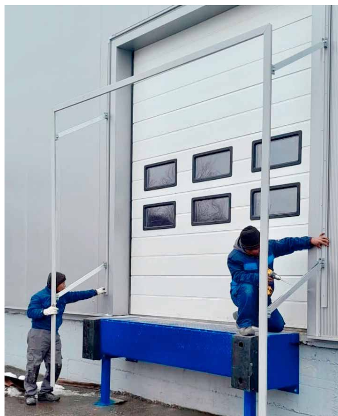
slika 13. Montaža mehaničke mini rampe Dock Shelter-a i industrijskih vrata
