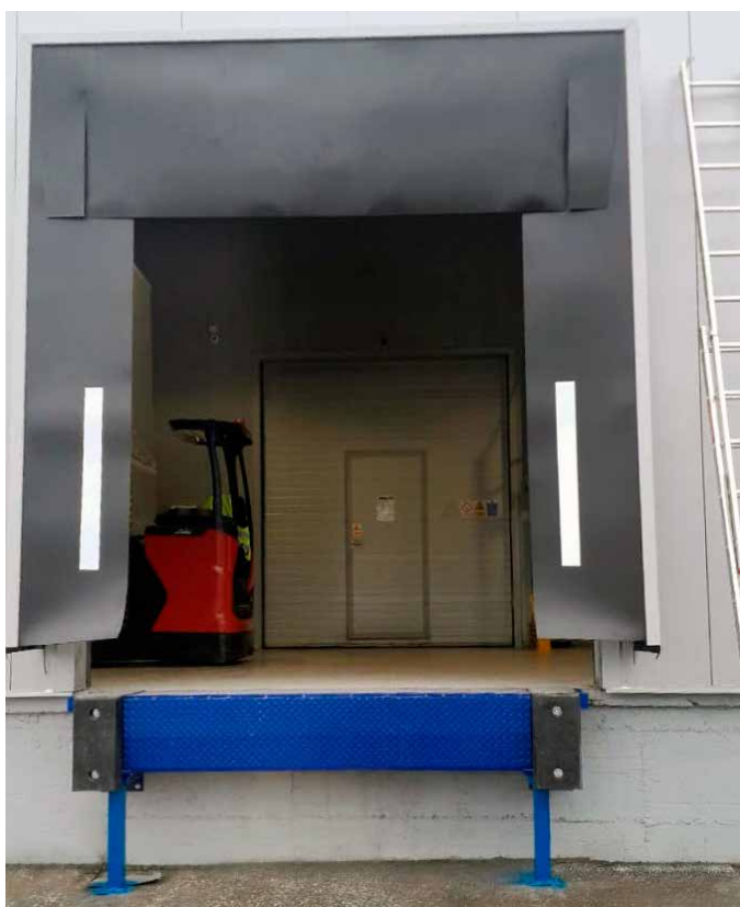
slika 12. Dichtung zavese (Dock Shelter) sa mehaničkom mini rampom
