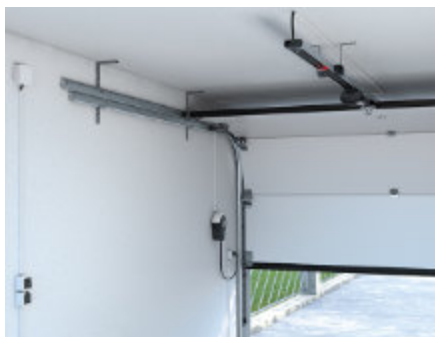
Postavljanje kućišta napred
